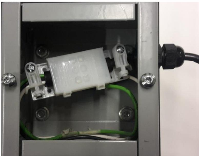
Fig. 43 プロジェクタ 74-00013-01 への電気接続完成図
